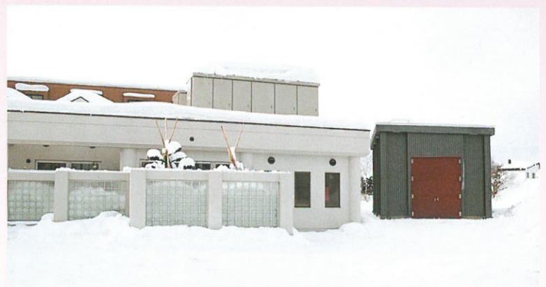
道路をはさんで設置された貯雪庫
